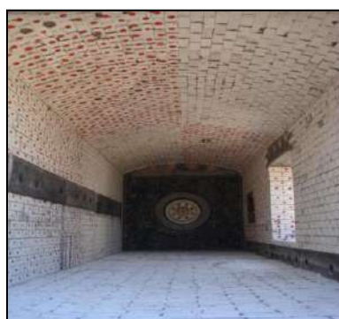
Горизонтальная установка 2 мВт
